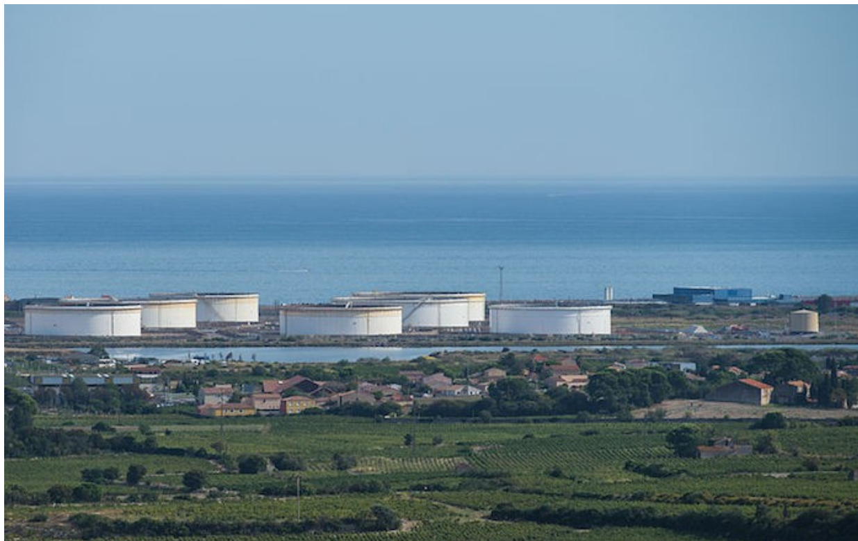
Un dépôt de pétrole à Frontignan (Hérault). Les 64 concessions d'hydrocarbures actuellement en cours de validité en France ne couvrent que 1 % de la consommation hexagonale, soit 815.000 tonnes de pétrole en 2016. Le reste est importé.
